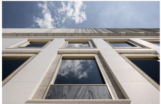
Die Prominenz des Standorts bedingt auch den Fokus auf die äußere Erscheinung und die Verbindung zum Umfeld. Das „neue Kleid“ übernimmt exakt das Fugenbild der ursprünglichen Steinfassade – jede Fuge der Platten wurde 3D-gescannt und neu geschnitten und wie ein neuer Stoff um das Gebäude gewoben, mit verarbeiteten Nähten und Rändern.
