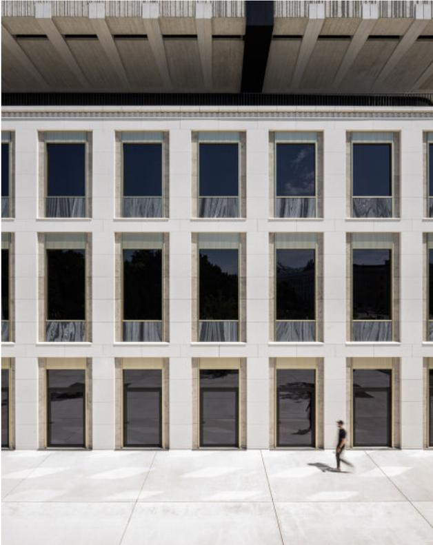
Mit diesem Projekt wird in Wien seit langem wieder eine großflächige Natursteinfassade (insgesamt 2.500 m<sup>2</sup>) realisiert. Der helle Kalkstein aus Kroatien zeichnet sich durch eine geringe Wasseraufnahme und ein dichtes Gefüge aus. Er erwärmt sich zudem kaum, speichert die Wärme nur in geringem Ausmaß und wirkt so der Aufheizung in der Stadt entgegen. Ein Naturprodukt mit den besten Eigenschaften für ein gutes Stadtklima und einer unschlagbaren Ökobilanz. **Manfred Breitwieser**
